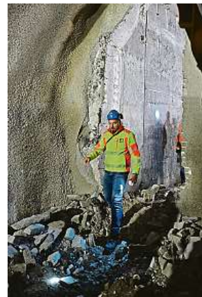
Spojovacím tunelem budou jezdit vlaky do depa Kačerov.
