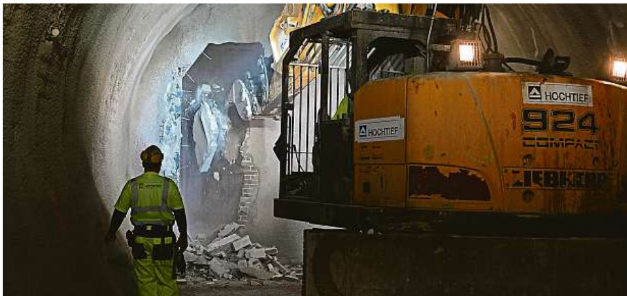
V současnosti je vyraženo celkem 2600 metrů tunelů a přibližně 84 procent z celkového objemu plánovaných ražeb.
