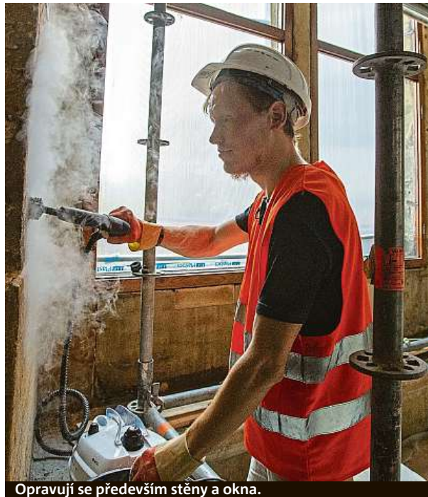
Opravují se především stěny a okna.
