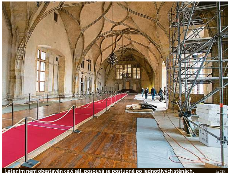
Lešením není obestaven celý sál, posouvá se postupně po jednotlivých stěnách.
