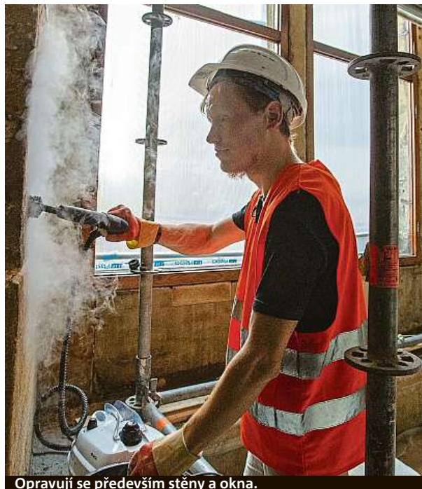
Opravují se především stěny a okna.
