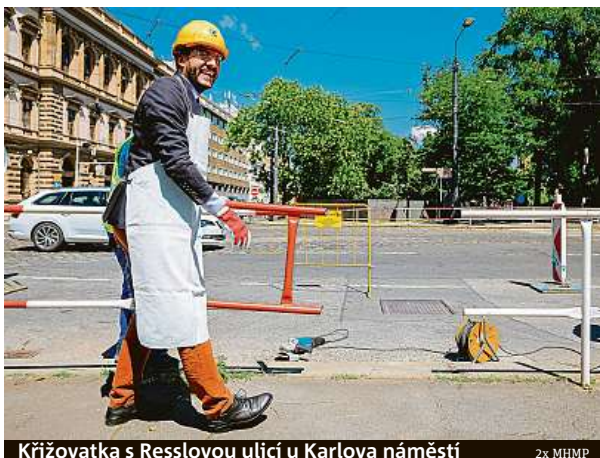
Křižovatka s Resslovou ulicí u Karlova náměstí
