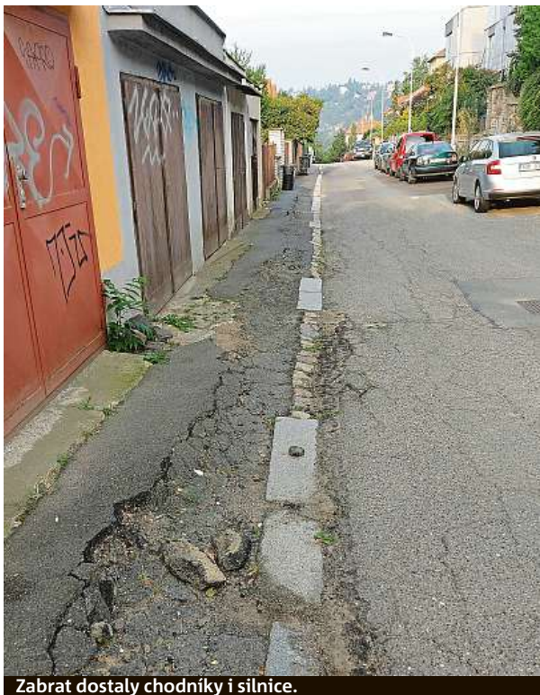
Zabrat dostaly chodníky i silnice.
