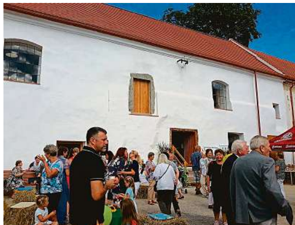
Venkov má chuť stále více ožít. Hvoždany opravily starý špejchar.
