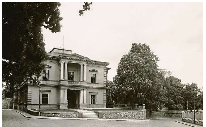
Průčelí Lannovy vily v průhledu Pelléovou ulicí. Foto Trousil, kolem roku 1935 4x MMP
