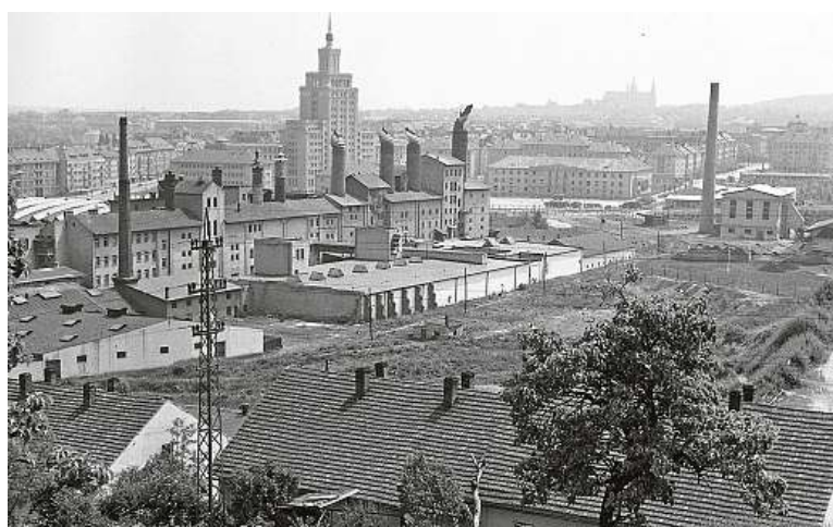
Pohled na území bývalých cihelen v době, kdy přibýly věže hotelu International, 1960
