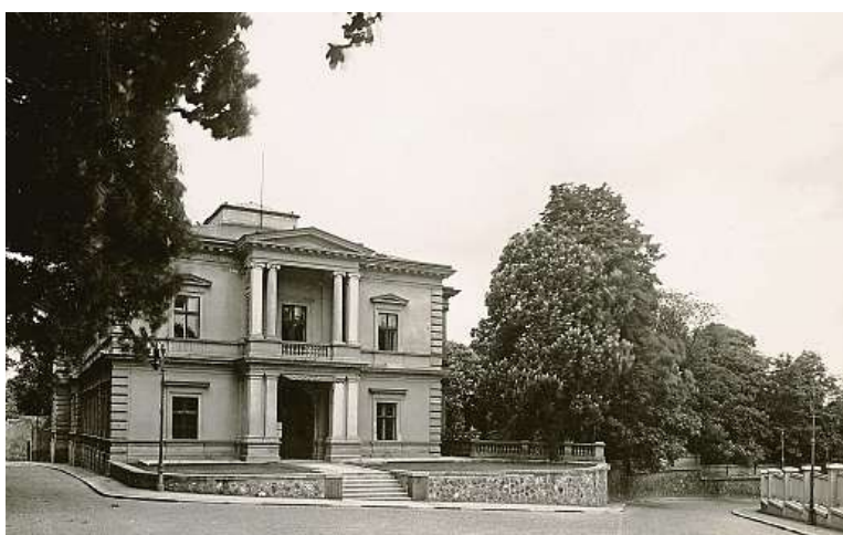
Průčelí Lannovy vily v průhledu Pelléovou ulicí. Foto Trousil, kolem roku 1935 4x MMP
