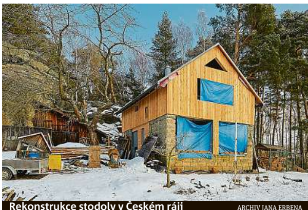
Rekonstrukce stodoly v Českém ráji
