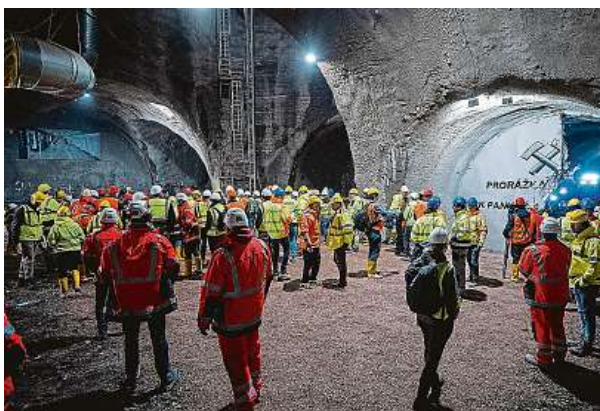
Dělníci loni v rámci stavby metra D prorazili poslední metry ze spojovacího tunelu z Pankráce do stanice Olbrachtova. MAFRA
