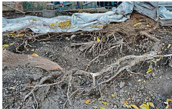
Vydouvání dlažby kolem stromů má být minulostí. Lidé z Technické správy komunikací kopou v ulicích podzemní cestičky. 4x TSK
