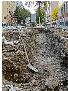
Postupem času začaly kořeny mohutnět a narušovat dlažbu.
