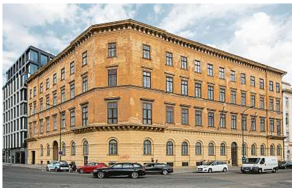
Desfourský palác byl postaven v pozdně klasicistním stylu v letech 1845 až 1847. Architektem byl Josef Kranner.
