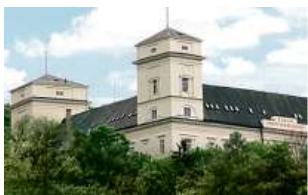
Zámek Račice, přestavba
