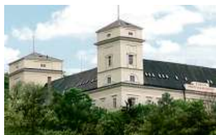
Zámek Račice, přestavba
