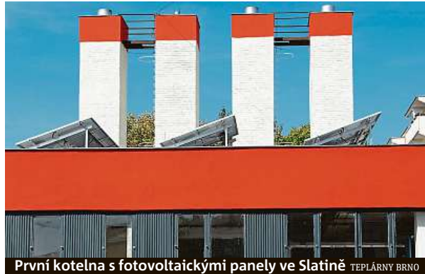
První kotelna s fotovoltaickými panely ve Slatině TEPLÁRNY BRNO
