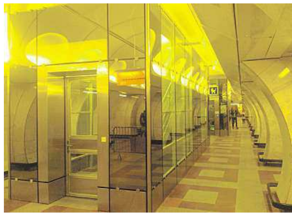
Na nástupišti má výtah zrcadlovou úpravu.
