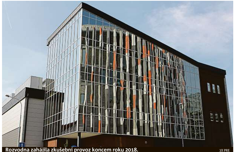
Rozvodna zahájila zkušební provoz koncem roku 2018.
