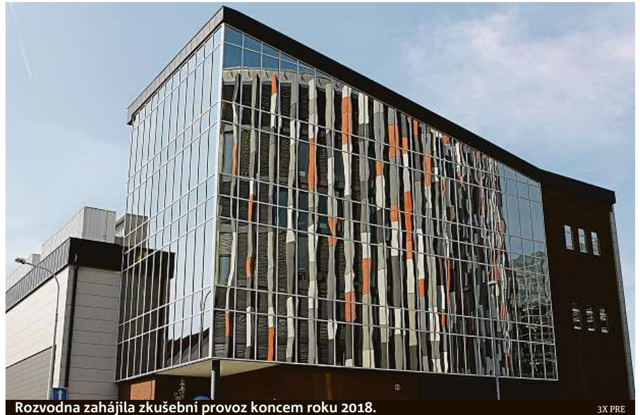
Rozvodna zahájila zkušební provoz koncem roku 2018.
