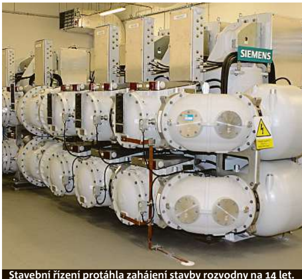
Stavební řízení protáhla zahájení stavby rozvodny na 14 let.
