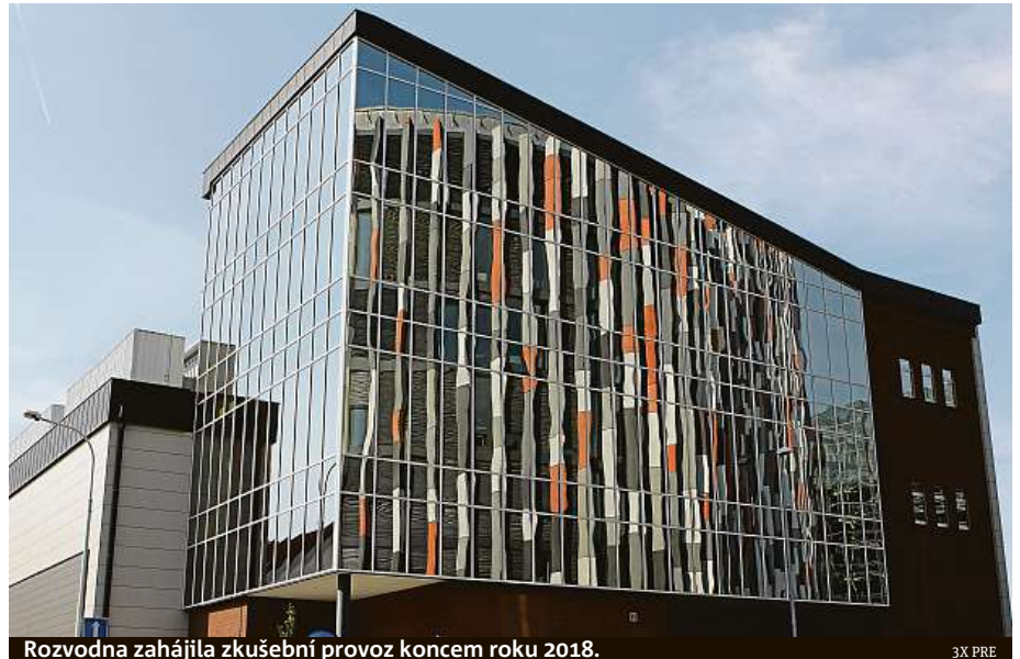
Rozvodna zahájila zkušební provoz koncem roku 2018.
