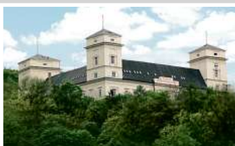
Zámek Račice, přestavba
