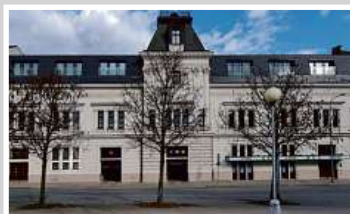
Multifunkční budova, Brno
