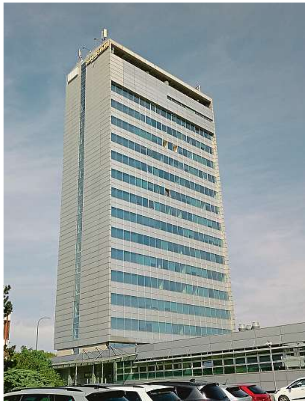
Výšková budova byla postavená na začátku 70. let minulého století na okraji přírodní rezervace Divoká Šárka.
