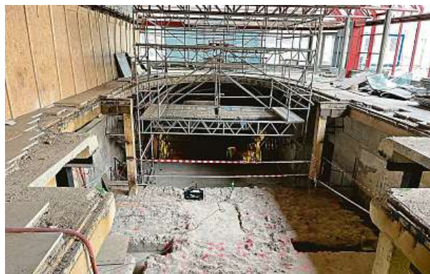
Rekonstrukcí prochází také vestibul stanice Českomoravská.
