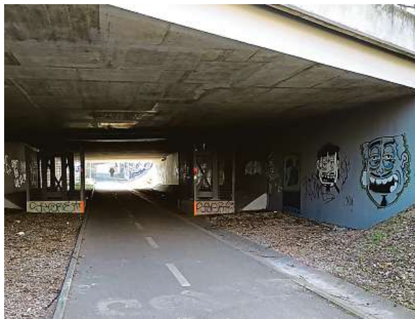
Na stojkách jsou osazeny podélné ocelové nosníky. METRO
