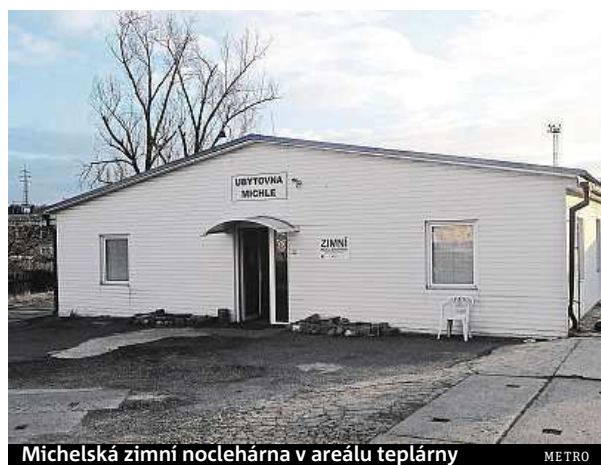
Michlešská zimní noclehárna v areálu teplárny METRO
