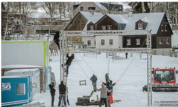
Na tratích závodů i na stadionu v Bedřichově se intenzivně pracuje.
