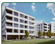
Bytové domy Břeclav, ul. Charvátská
