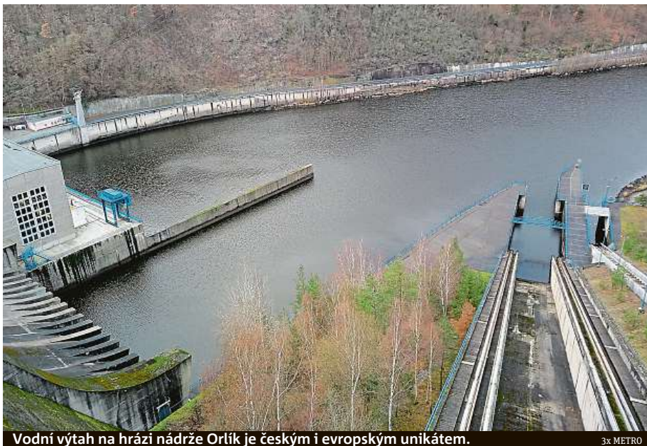
Vodní výtah na hrázi nádrže Orlík je českým i evropským unikátem.
