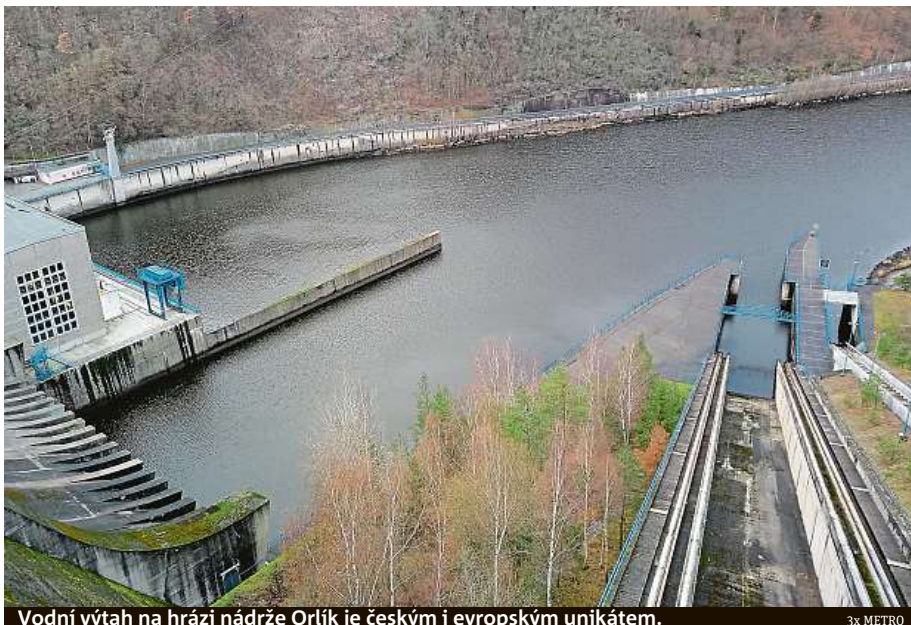
Vodní výtah na hrázi nádrže Orlík je českým i evropským unikátem.
