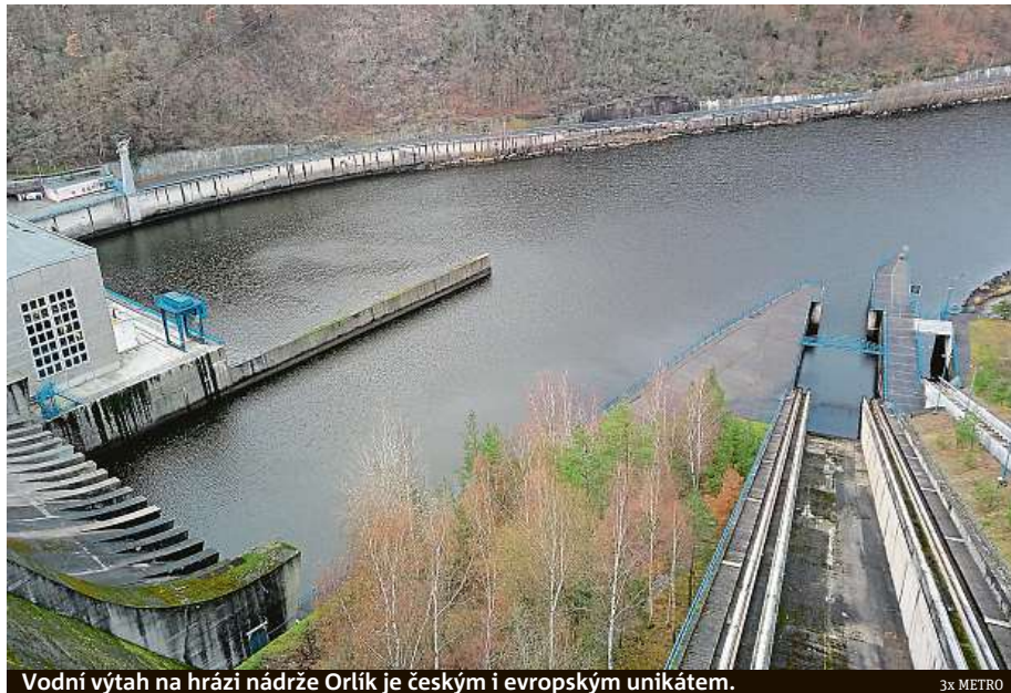
Vodní výťah na hrázi nádrže Orlík je českým i evropským unikátem.
