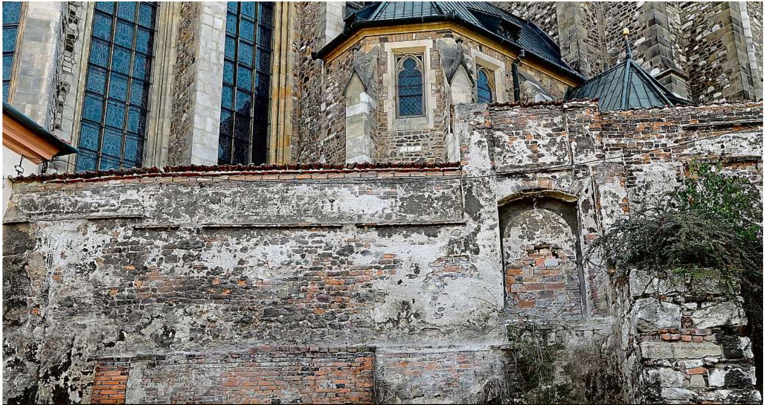
Opěrná zed' Petrova byla postavena v éře přemyslovských králů.
