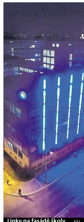
Linky na fasádě školy
