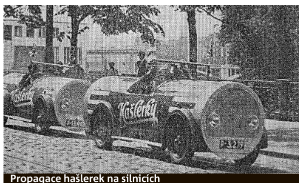
Propagace hašlerek na silnicích
