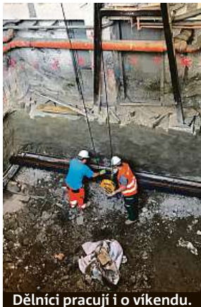
Dělníci pracují i o víkendu.
