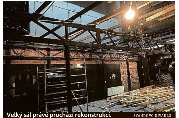
Velký sál právě prochází rekonstrukcí.
