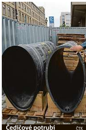
Čedičové potrubí ČTK
