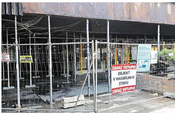
Pasáž blokuje podpěry, které drží terasu.
