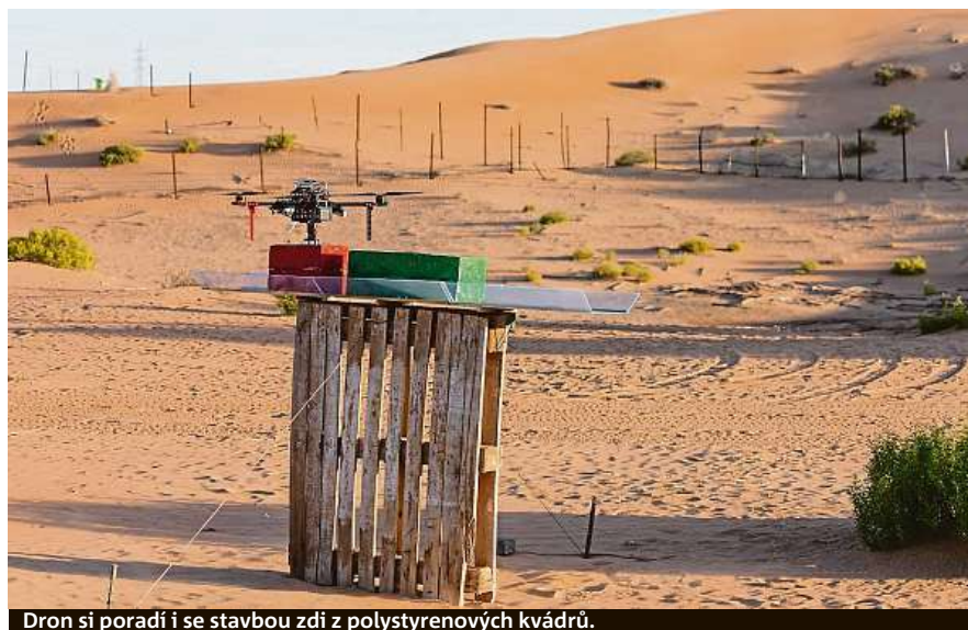
Dron si poradí i se stavbou zdi z polystyrenových kvádrů.
