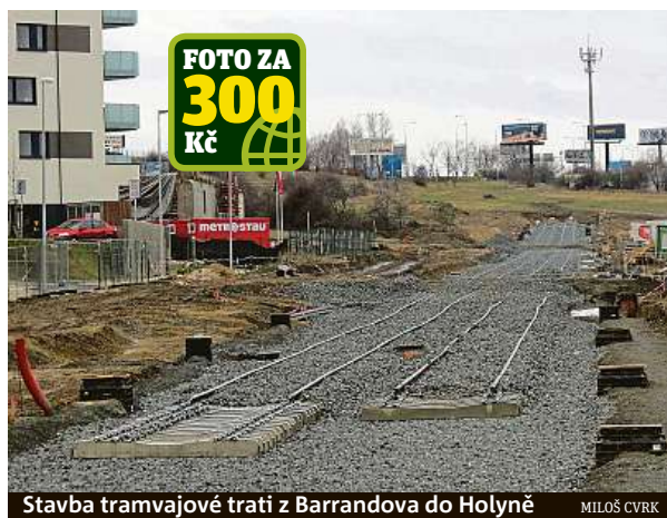
Stavba tramvajové tratě z Barrandova do Holyně
