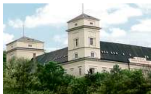
Zámek Račice, přestavba
