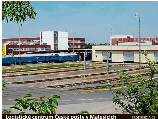
Logistické centrum České pošty v Malešicích
