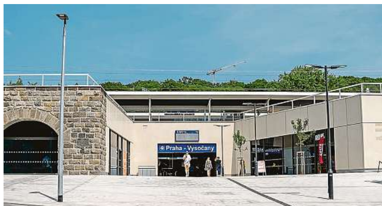
Na nádraží vznikla nová odbavovací hala, stará byla zdemolována loni. SPRÁVA ŽELEZNIC
