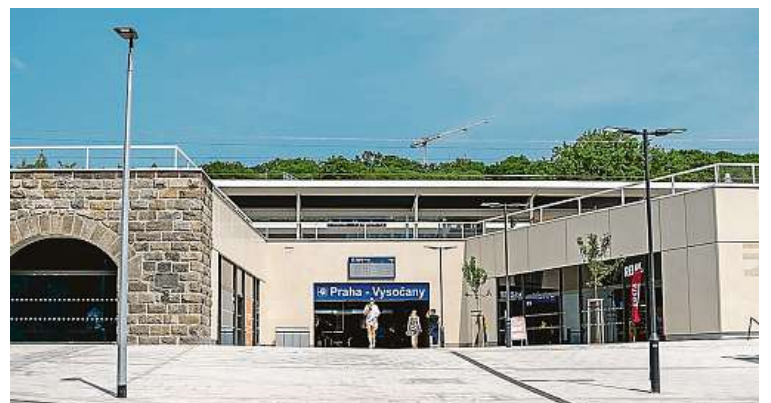
Na nádraží vznikla nová odbavovací hala, stará byla zdemolována loni. SPRÁVA ŽELEZNIC
