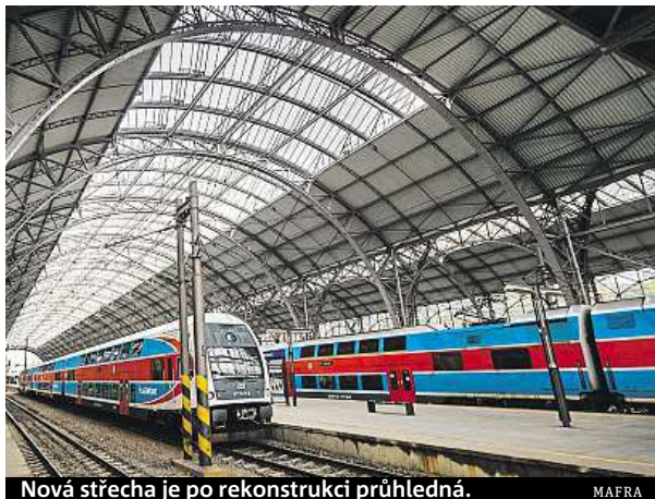
Nová střecha je po rekonstrukci průhledná.
