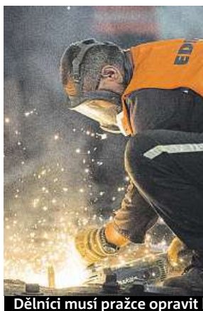
Dělníci musí pražce opravit kompletně.
