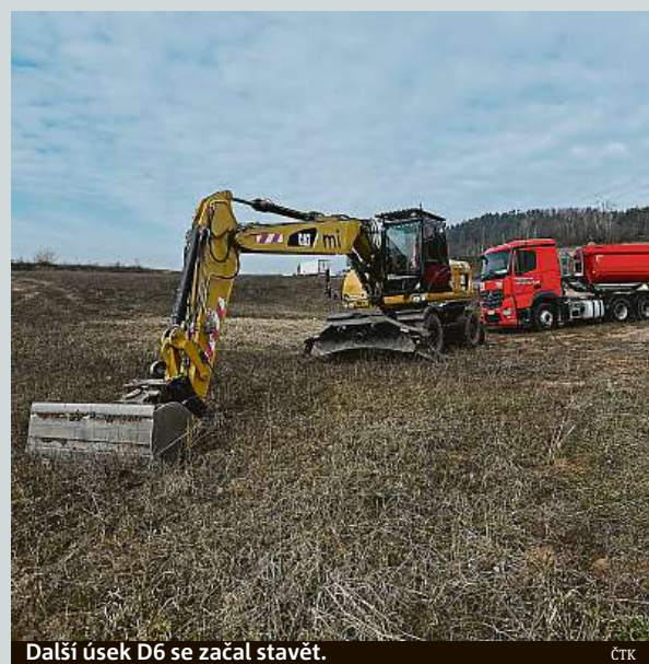
Další úsek D6 se začal stavět.
