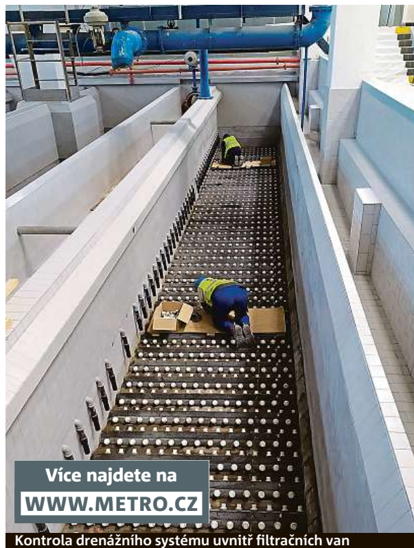
Kontrola drenážního systému uvnitř filtračních van
