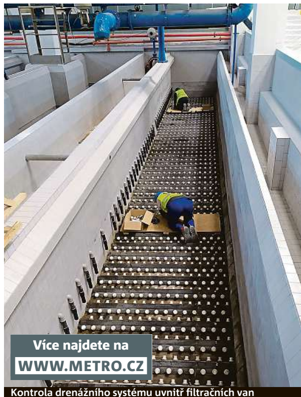
Kontrola drenážního systému uvnitř filtračních van
