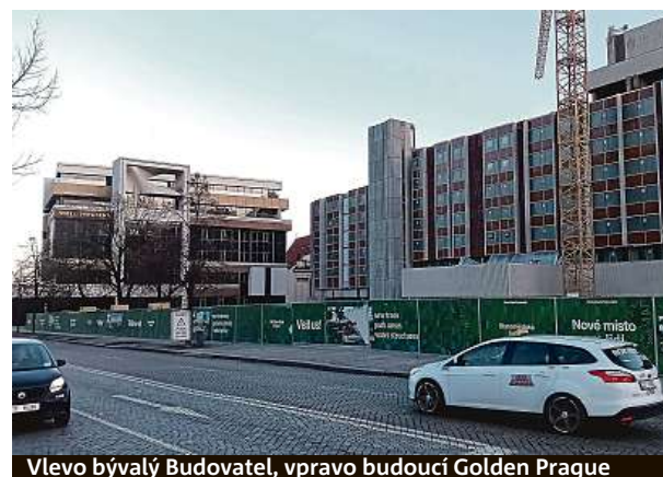
Vlevo bývalý Budovatel, vpravo budoucí Golden Prague
