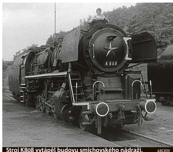
Stroj K808 vytápěl budovu smíchovského nádraží.
